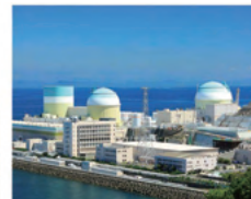
原子力発電所
