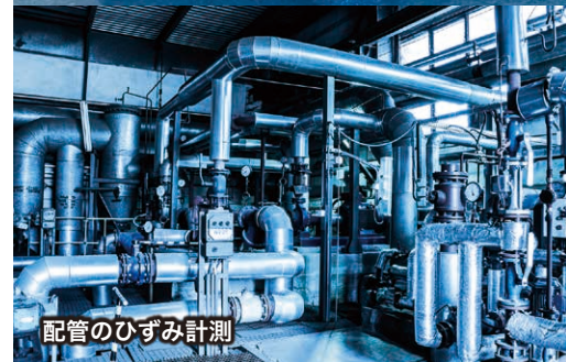
ブレーキや配管のひずみ計測
